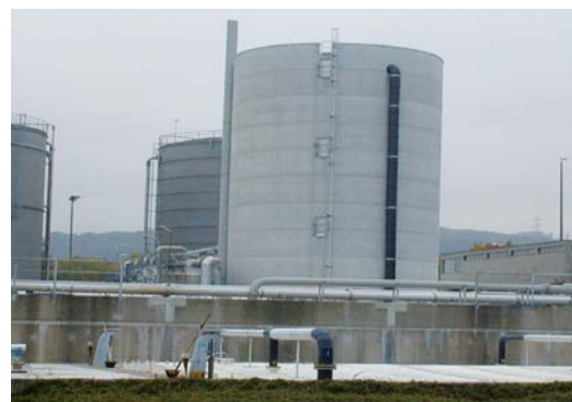
Průmyslový skrápěný filtr s výškou výplně 16 m región Basel, Švýcarsko
